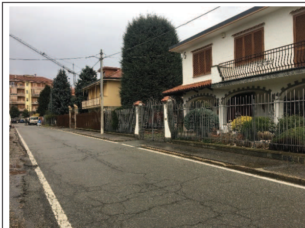
Vista edifici lungo via Cesare Beccaria
