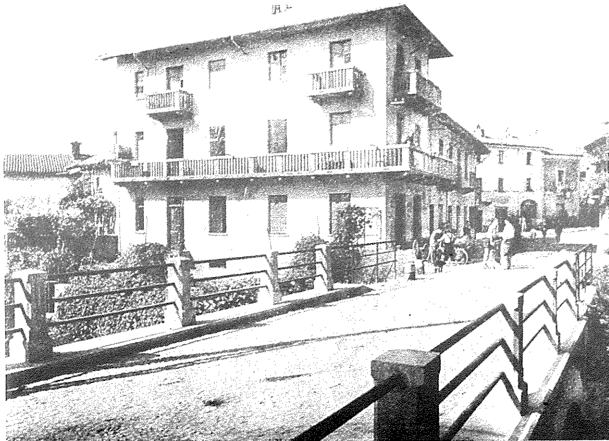
PIOSSASCO - Ponte sul Sangone
