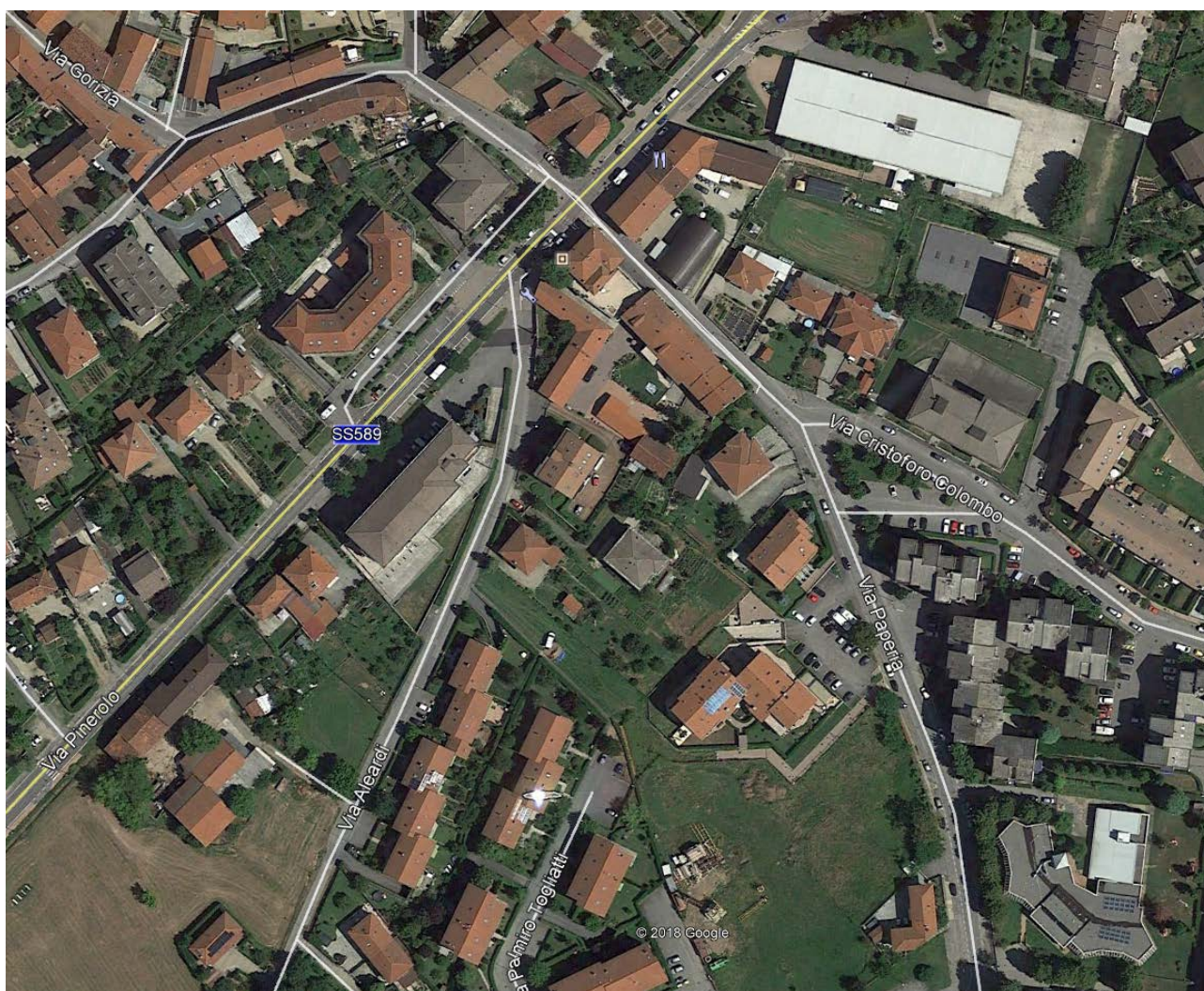
Foto aerea di inquadramento della zona di intervento nei pressi di via Torino
